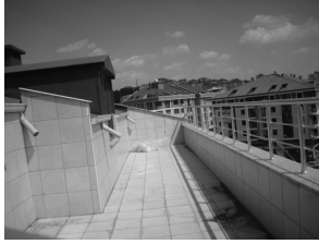
Çatı piyesinin önündeki teras, çatıda ucu açık yağmur suyu iniş boruları ve köşedeki süzgeç.
